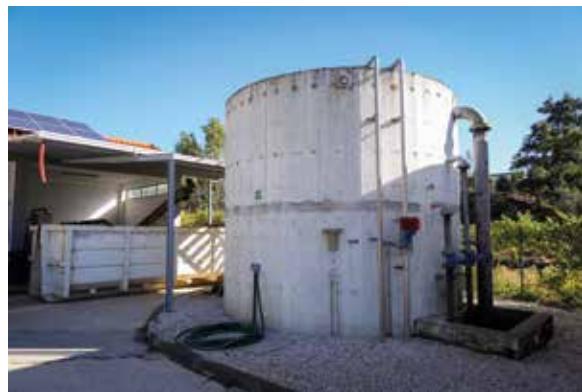
Espessador e contentor das lamas desidratadas
