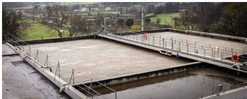
Tanques de arejamento
