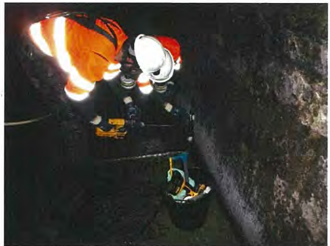
Instalação do medidor de nível
