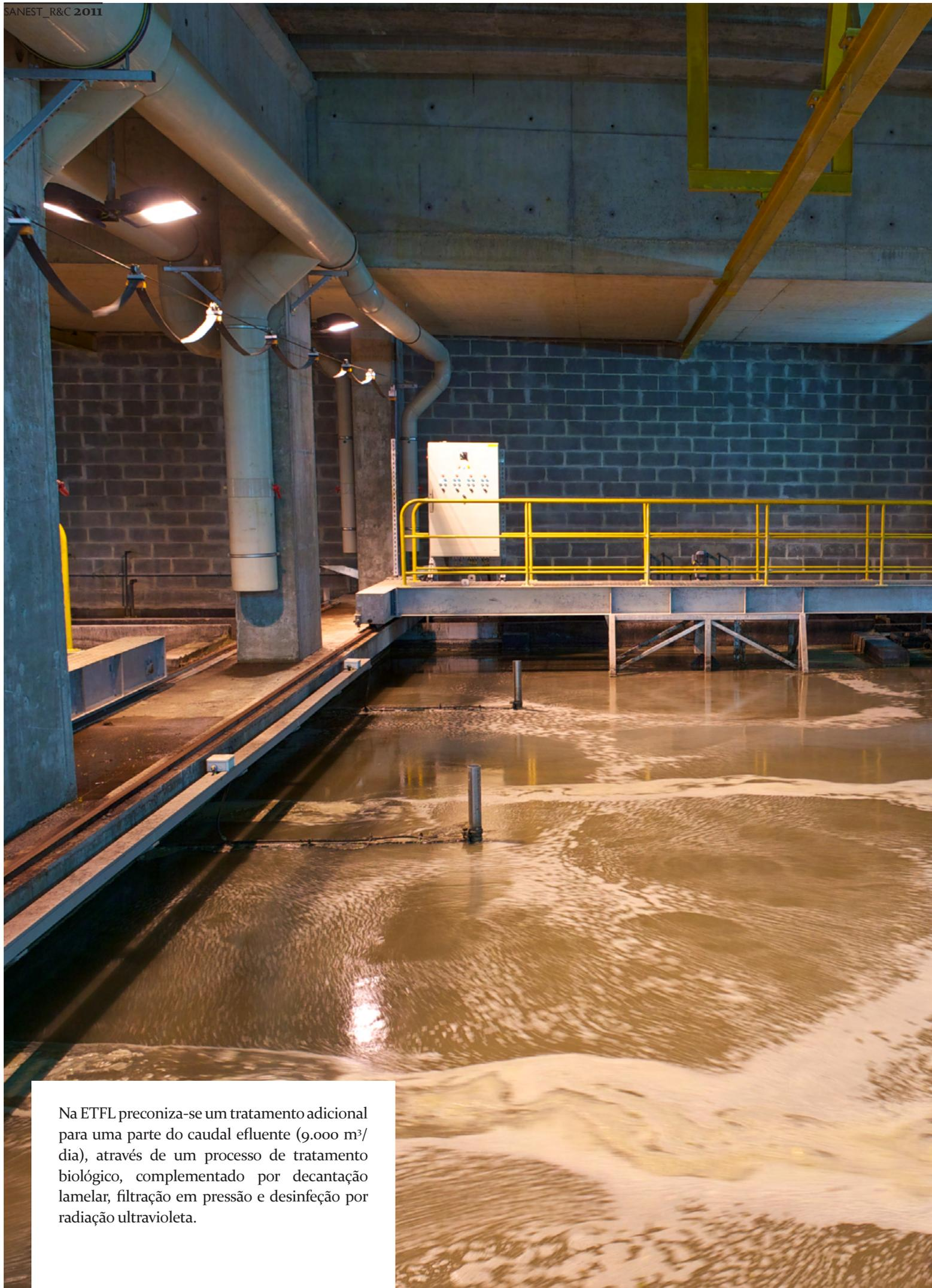
Na ETFL preconiza-se um tratamento adicional para uma parte do caudal efluente (9.000 m<sup>3</sup>/dia), através de um processo de tratamento biológico, complementado por decantação lamelar, filtração em pressão e desinfecção por radiação ultravioleta.
