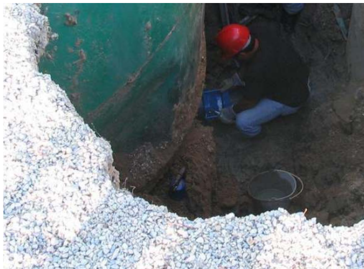
Actividade de Manutenção de infra-estruturas
