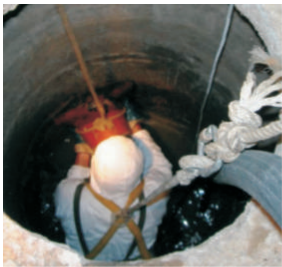
Actividade de Manutenção de infra-estruturas
